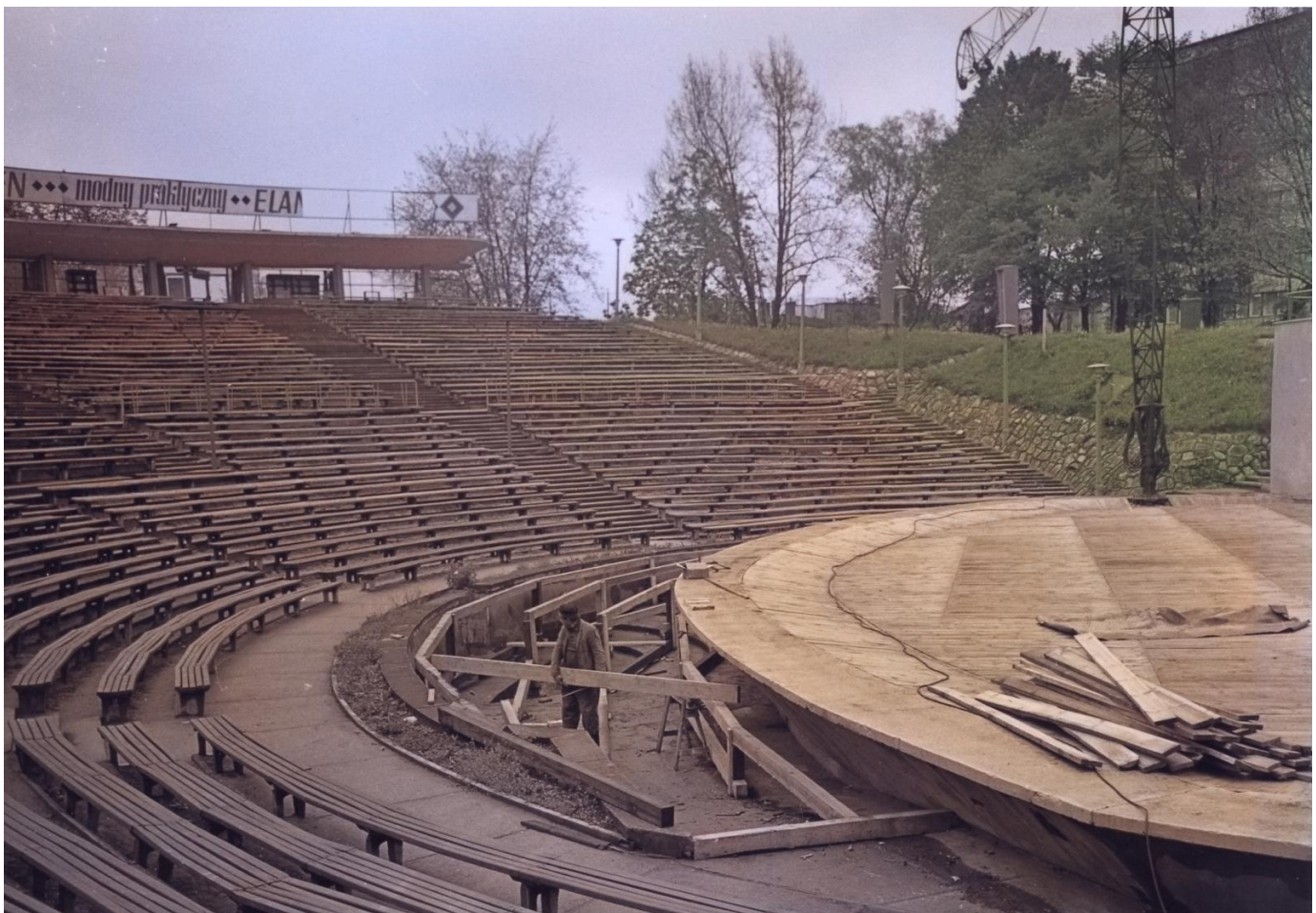
Prace budowlane, fot. Tadeusz Horoszkiewicz
