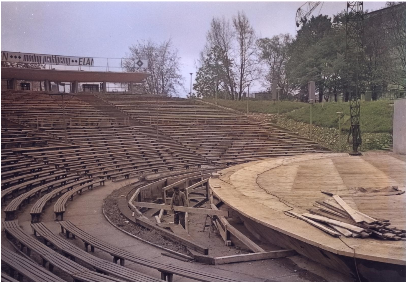
Prace budowlane, fot. Tadeusz Horoszkiewicz
