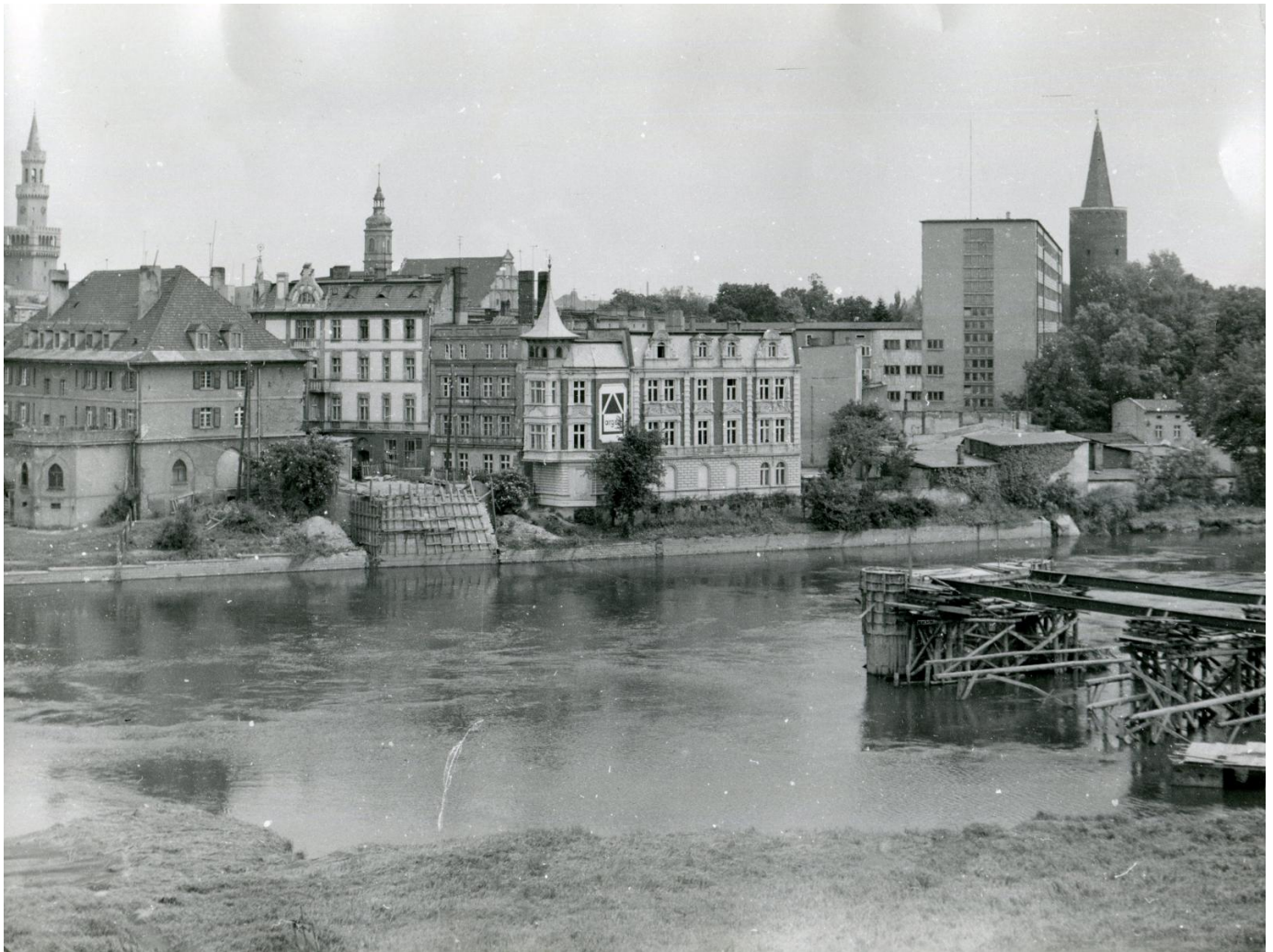
Zniszczony most na Odrze, ok. 1945 roku
