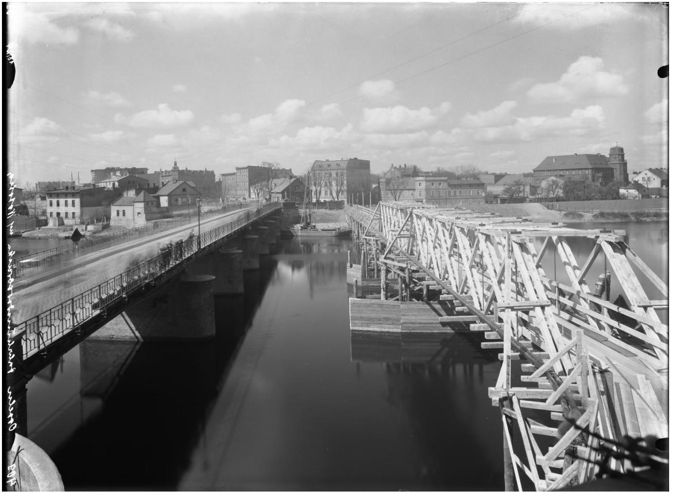
Most Stulecia w trakcie kapitalnego remontu, ok. 1932 roku
