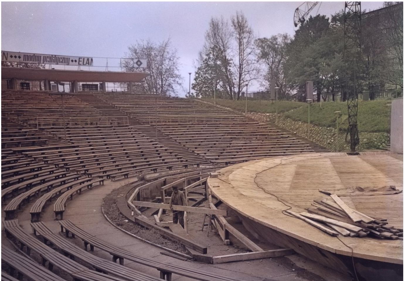
Prace budowlane, fot. Tadeusz Horoszkiewicz
