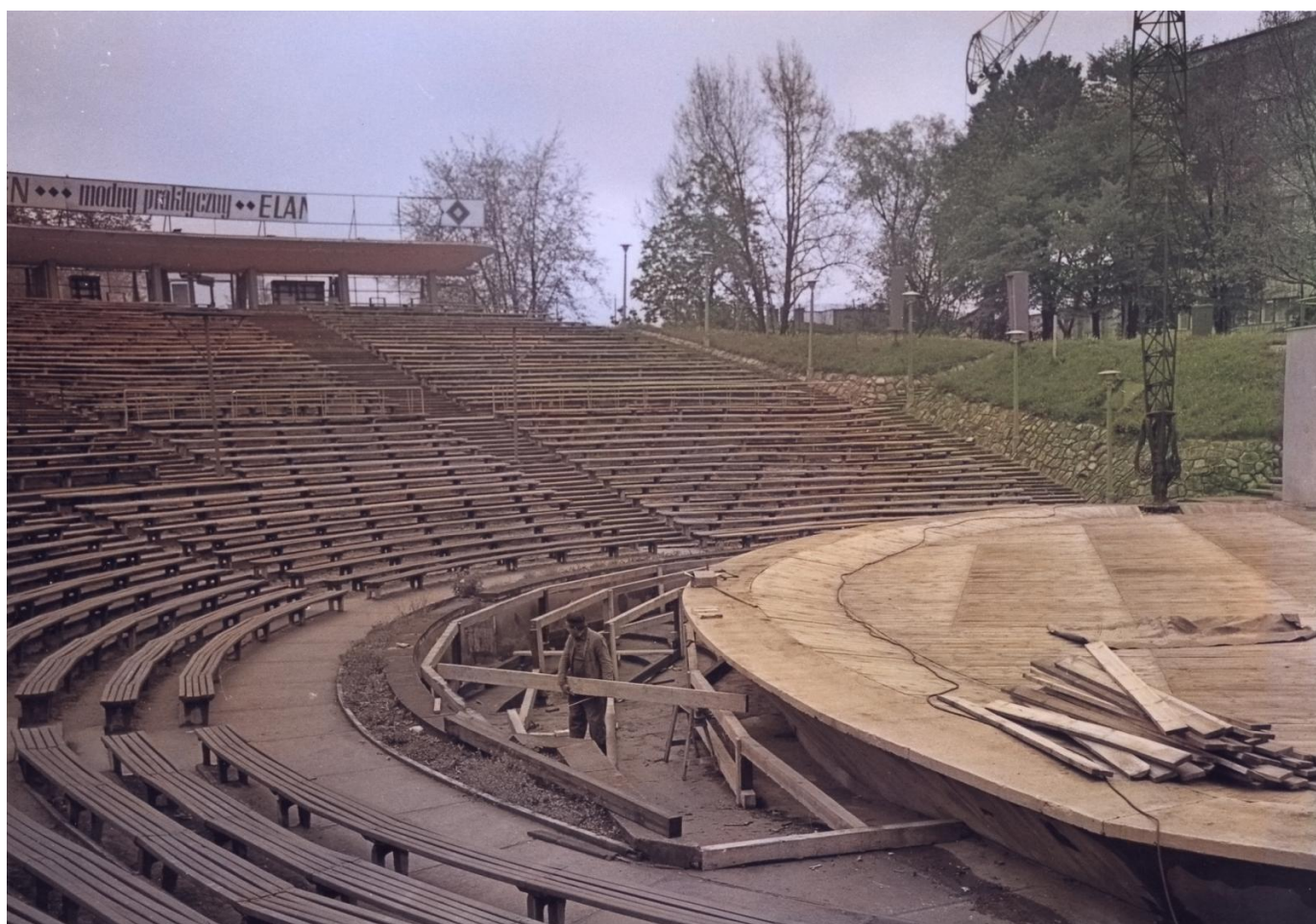
Prace budowlane, fot. Tadeusz Horoszkiewicz
